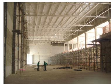
Obra 63% executada, shell do cinema entregue. Em execução o fechamento dos skylights, as instalações elétricas, hidráulicas e o ar condicionado. O shopping conta com 92% da ABL comercializada.
