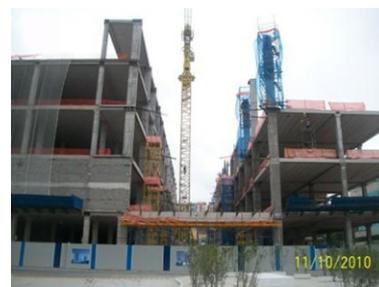
Obra mais de 41% executada. Laje da cobertura já concretada e iniciada a cobertura do atrium. Alvenaria e estrutura metálica também se encontram em fase avançada. O Shopping já conta com 40% da ABL comercializada.
