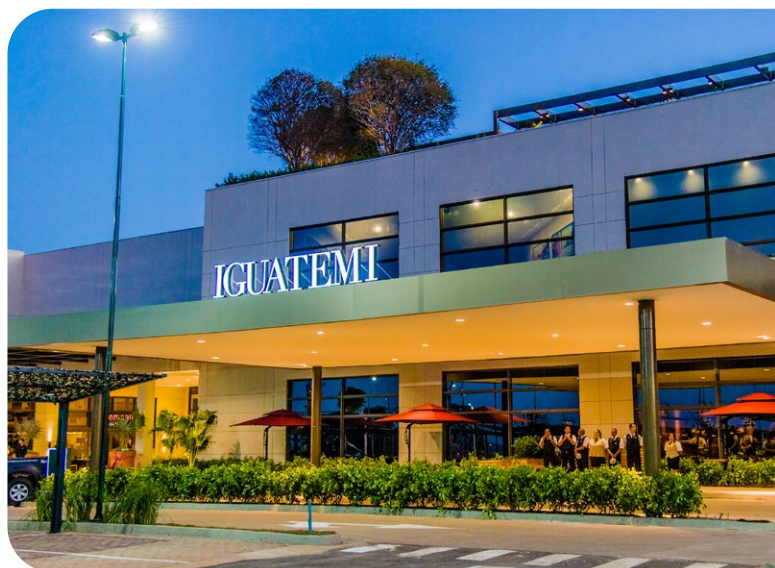
Fachada do Iguatemi São José do Rio Preto
