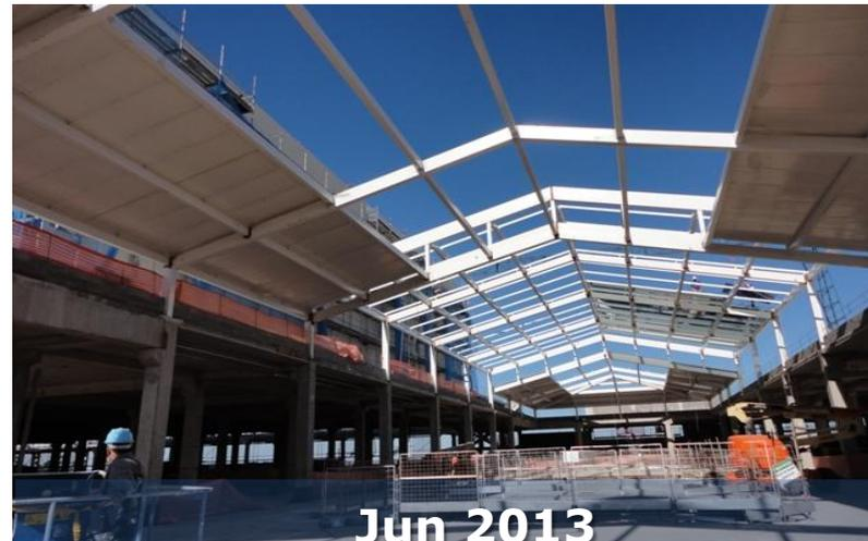
Estrutura de concreto em fase final. Serviços em andamento: estrutura metálica, alvenarias e instalações e coberturas e área externa. A obra está em linha com o cronograma, com 26% concluída. 73% da ABL comercializada.
