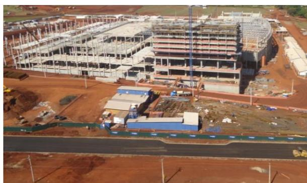
Estrutura de concreto em fase final. Estruturas metálicas de coberturas e Skylights iniciadas. Instalações prediais e sistemas de ar condicionado em andamento acelerado. 80% da ABL comercializada.
